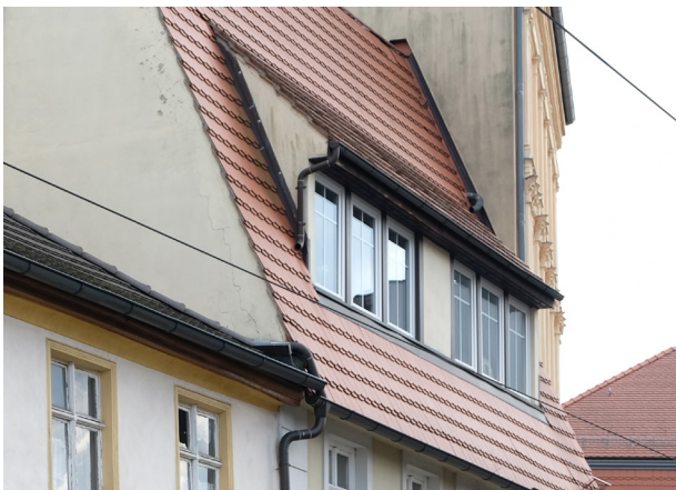
SANDOWER STRASSE Schleppdachgaube
