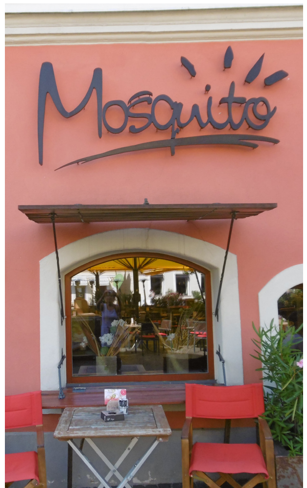
ALTMARKT 22 | Mittelalterliche Fensteröffnungen, sogenannte „Scharren“, zum Warenverkauf
