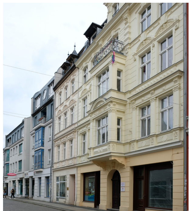
MÜHLENSTRASSE Vorspringender Erker und Balkon
