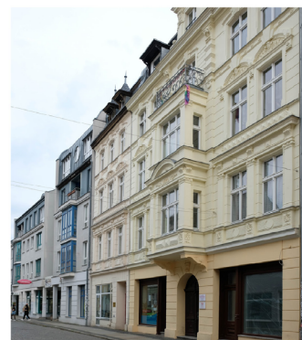
MÜHLENSTRASSE Vorspringender Erker und Balkon
