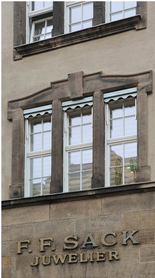
SPREMBERGER STRASSE Sonnenschutzelemente innerhalb der Gewände
