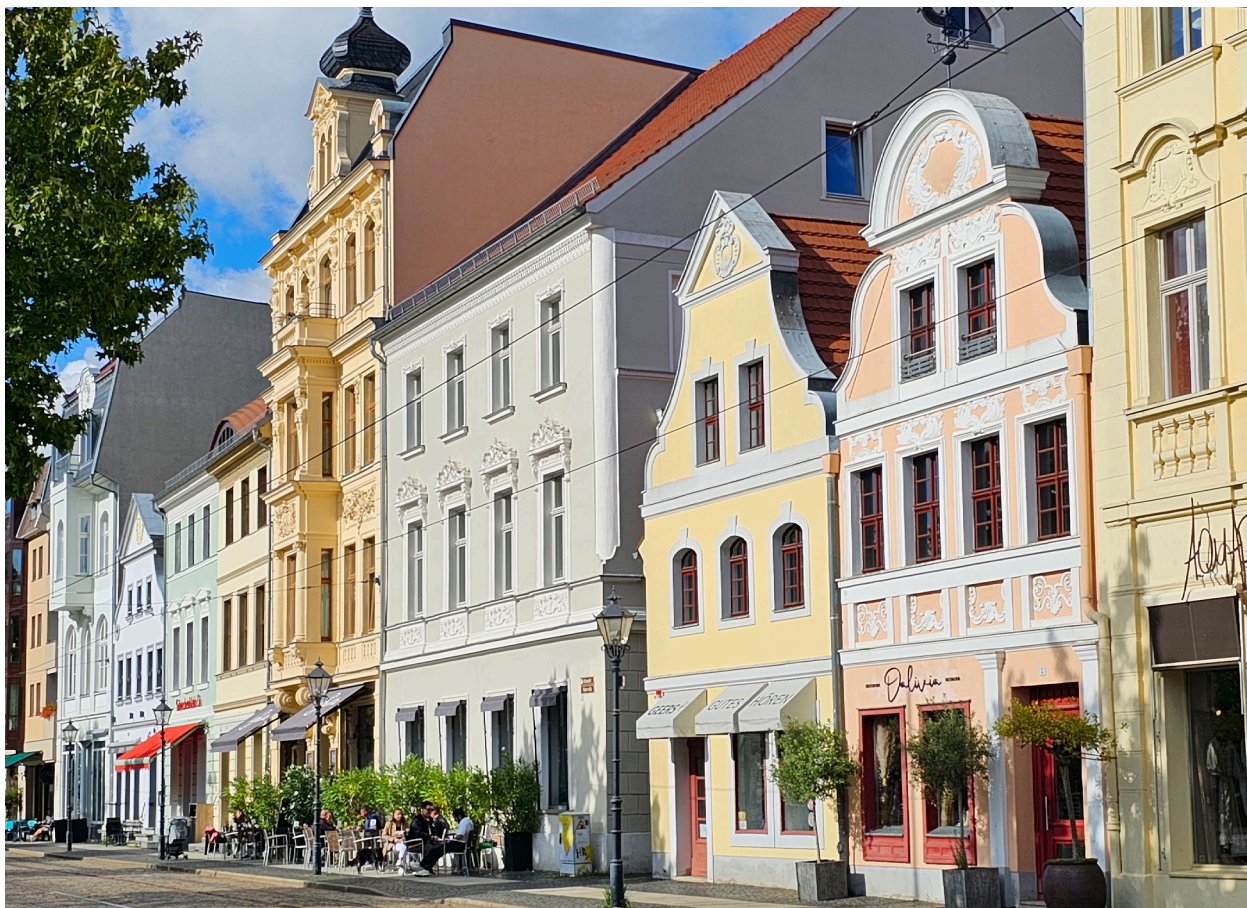
ALTMARKT | Mineralische Putzfassaden in pastelligen Farben waren über viele Bauepochen hinweg ein stadtbildprägendes Merkmal der Cottbuser Altstadt
