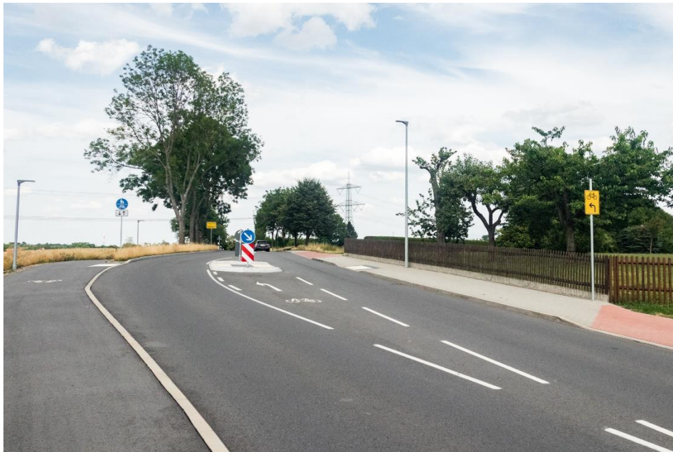
Abbildung 45: Mittelinsel mit vorgelagerter Aufstellfläche für abbiegenden Radverkehr (Quelle: Quelle: IGS)
